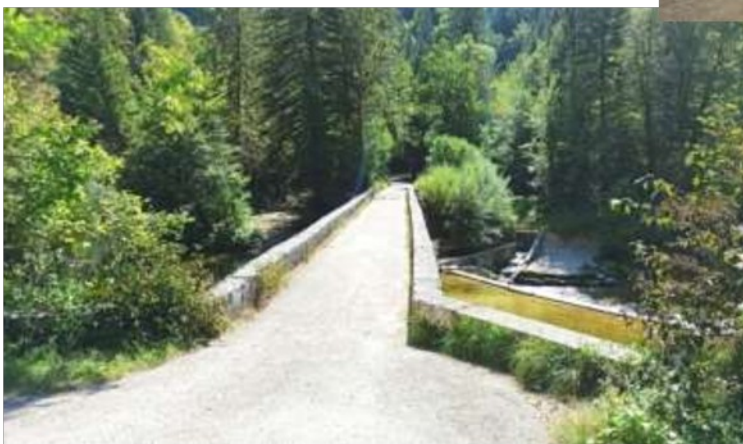
Traversée de la Bienne sous La Roche Blanche
