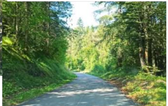
Voie communale au niveau de Noire Combe
